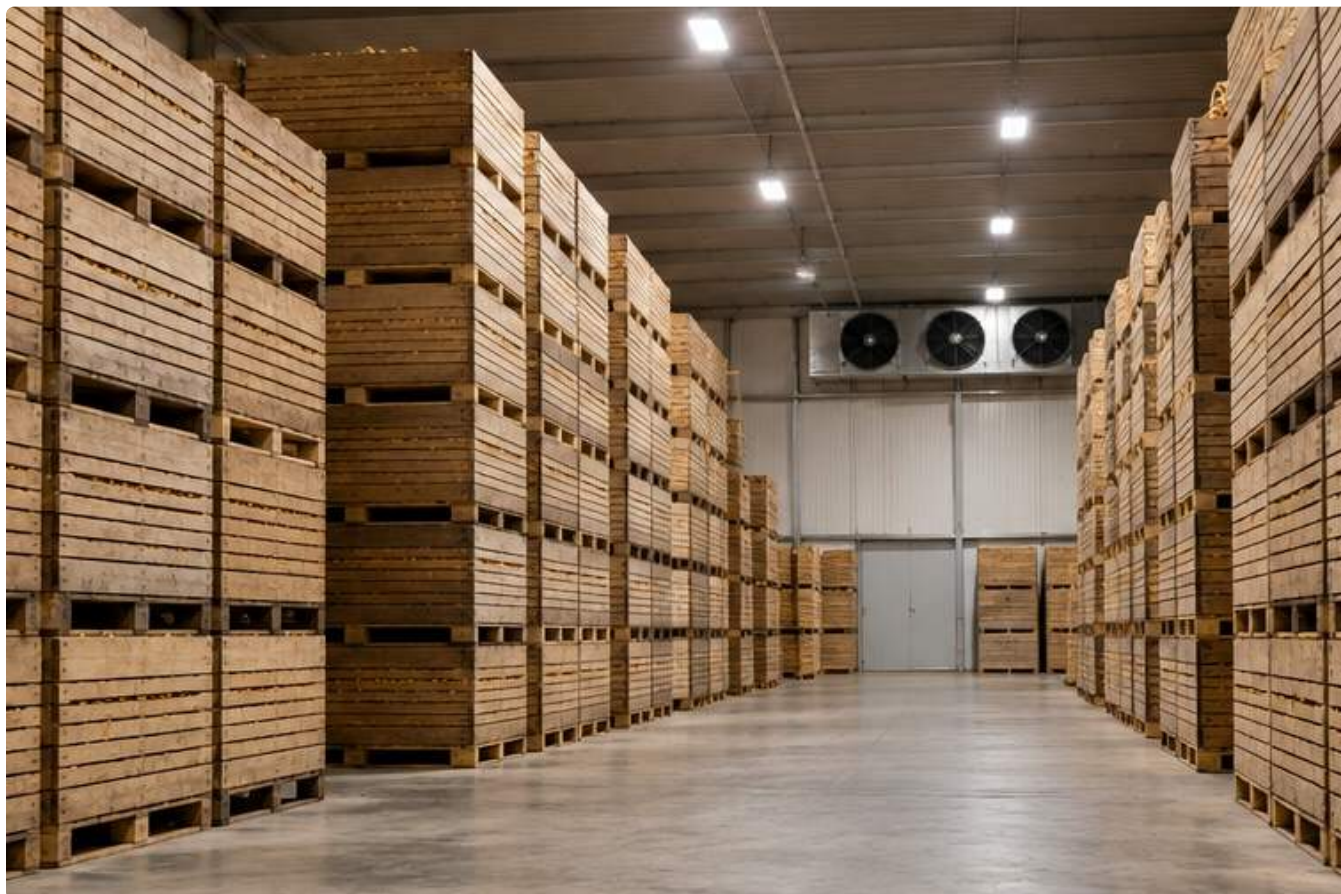
Magazzino per patate con cassoni impilati e sistema di ventilazione.
